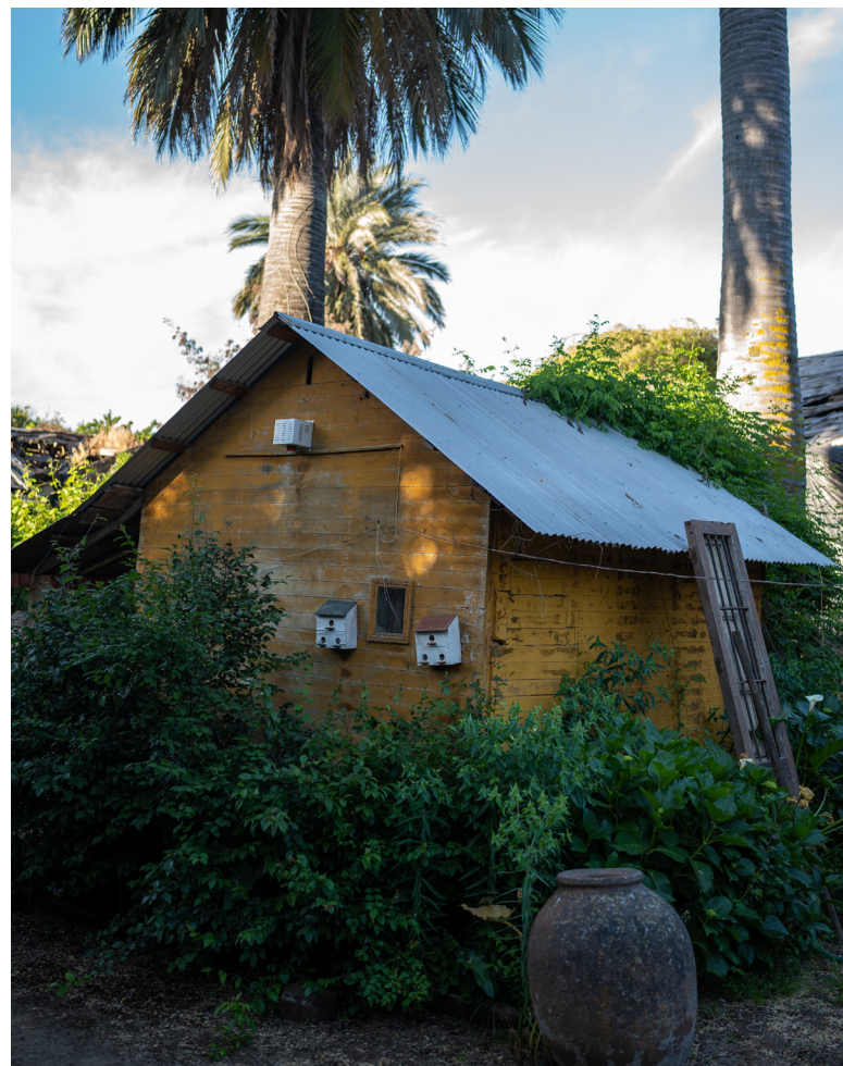
Figura 31. Refugio para terremotos, construido en madera, situado al centro del patio de la casona de la hacienda Alhué.
