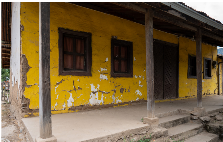
Figura 36. Casa piloto durante el proceso de reconstrucción post terremoto del año 1985. En la esquina inferior izquierda, se alcanza a apreciar el detalle del palillaje y el revestimiento en barro.
