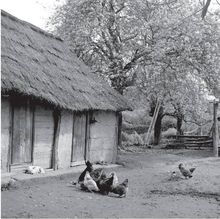
Figura 24. Vivienda en Villa Alhué, con muros de quincha y cubierta de “techo” (paja); ca. 1940-1960. Autor: Antonio Quintana Contreras. Colección Archivo Central Andrés Bello, Universidad de Chile
